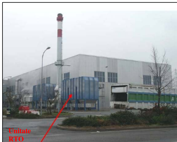
Figura 19: Biouscarea deseurilor cu unitate RTO
